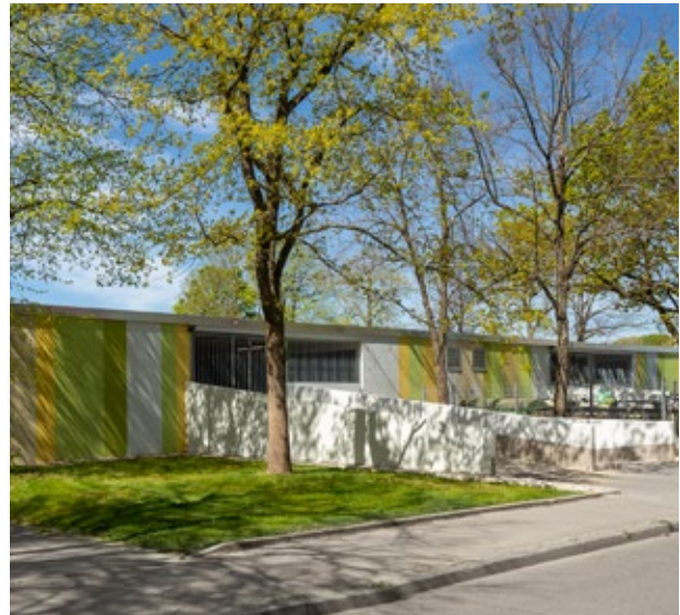
Die sanierte Tiefgarage Auwaldhof
