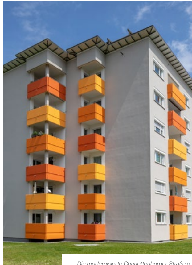
Die modernisierte Charlottenburger Straße 5
